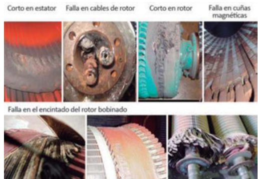
Figura 4. Fallas eléctricas en aerogeneradores.
